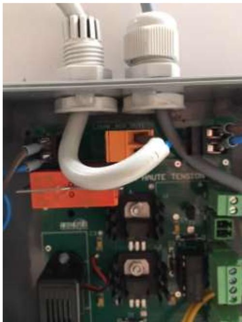
Vérifier que le fil neutre (bleu) est en bas et la phase (marron) en haut. Régler la longueur du câble en tirant dessus par le haut. Et serrer l'écrou du presse étoupe.
